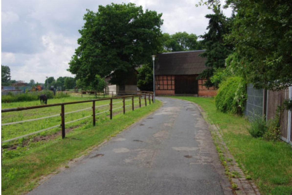
Croya Nr. 4: Erneuerung der Straße Bohldamm In Pflasterbauweise
