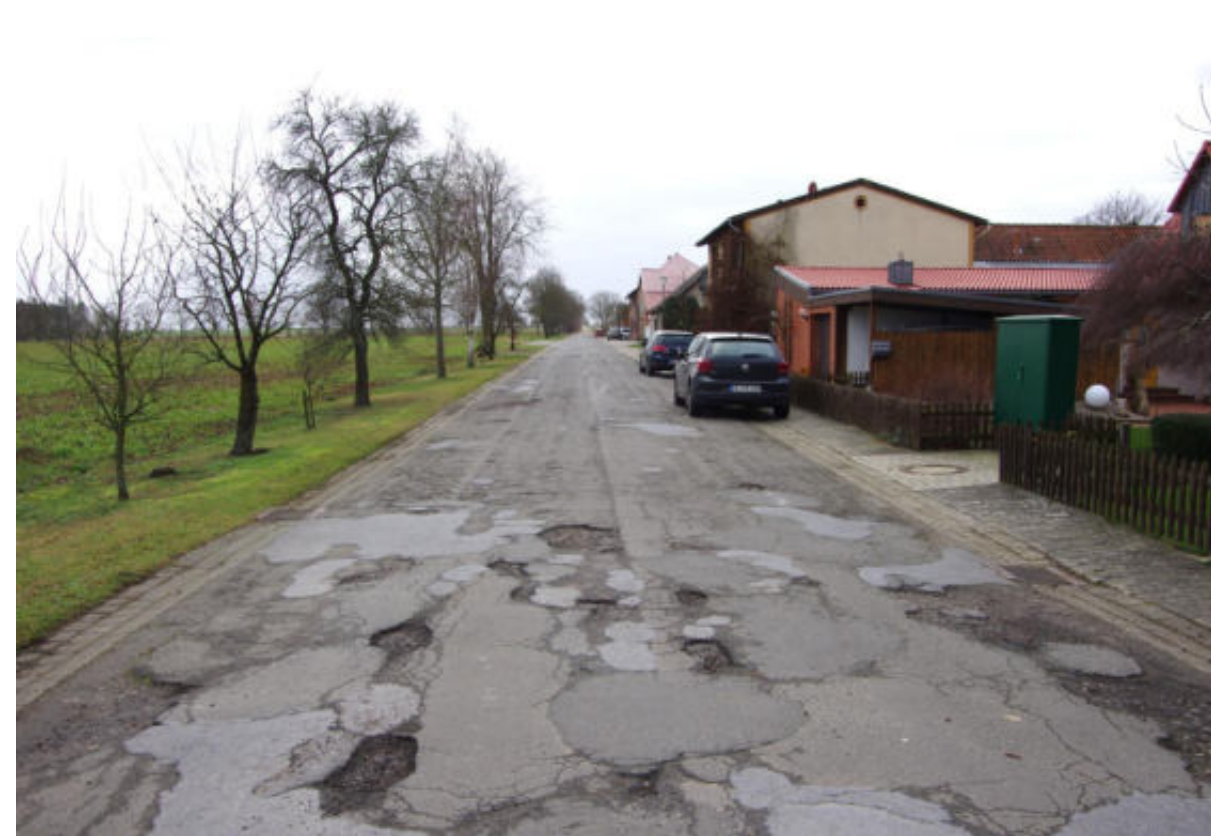
Altendorf Nr. 5: Erneuerung der Dörrheidenstraße (abgängiger Straßenraum in Asphaltbauweise erschließt die Siedlungsbebauung im Norden)
