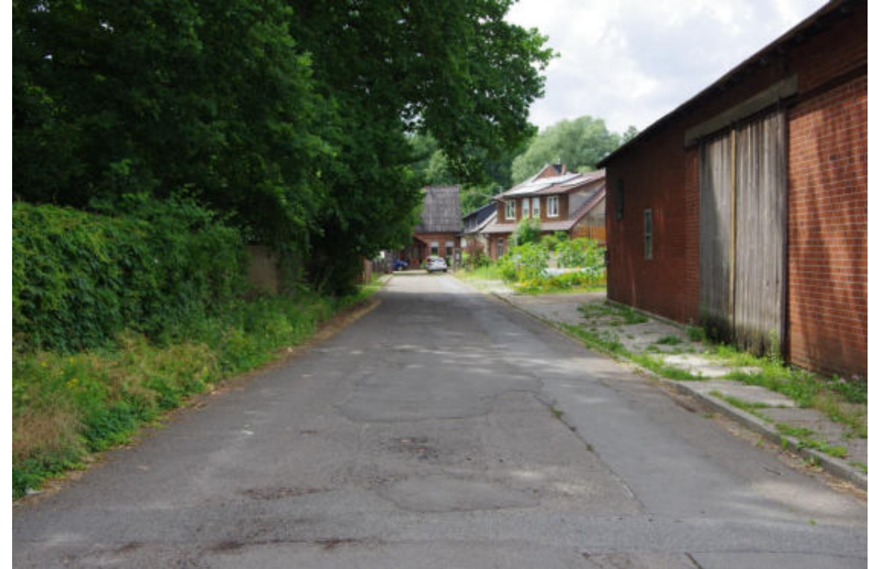
Croya Nr. 5: Erneuerung der Straße Alter Hof einschl. Schaffung einer fußläufigen Verbindung zum Bohldamm (Straßenraum dient der Erschließung der Hofgrundstücke im ursprünglichen Rundling)
