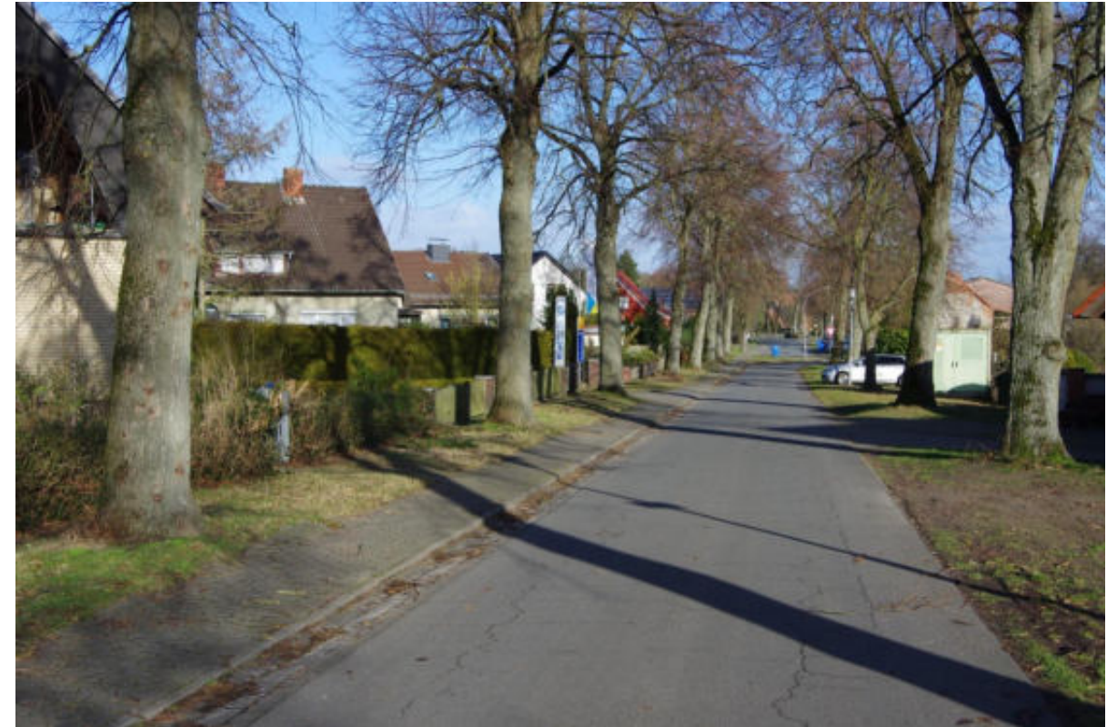
Zicherie Nr. 4: Umgestaltung Alter Schulweg (Wurzelwerk der Linden beeinträchtigt die Gehwegnutzung, Fußgänger benutzen die Fahrbahn, Abkürzungsverkehr Richtung Wolfsburg)
