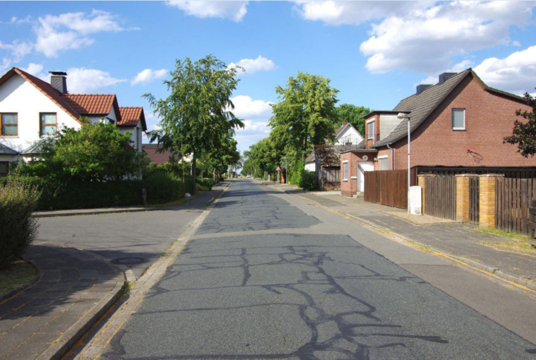
Tülau Nr. 16 Erneuerung der Kirchstraße (abgängige Asphaltbefestigung)
