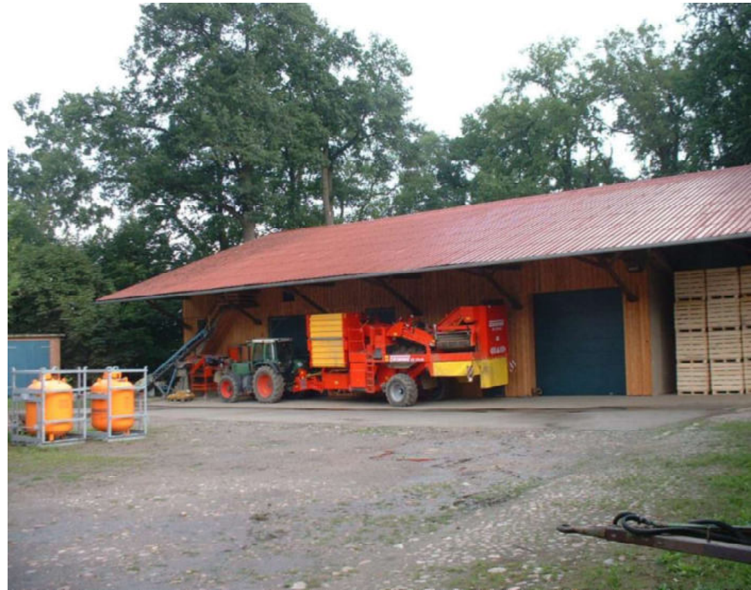
Nicht nur Tonziegel sind förderfähig Dacheindeckung in Oldendorf
