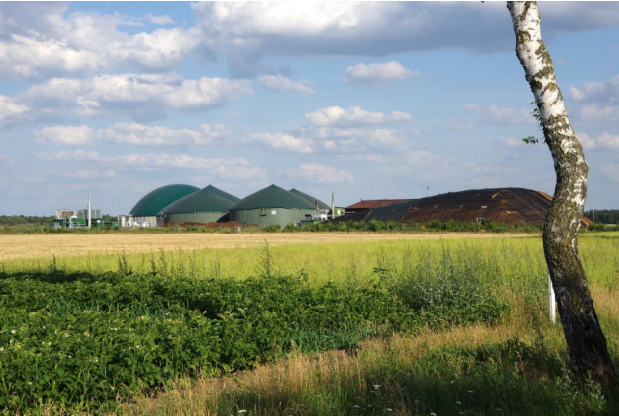
Erschließung ergänzender alternativer Einkommen - Biogasanlage (Tülau)
