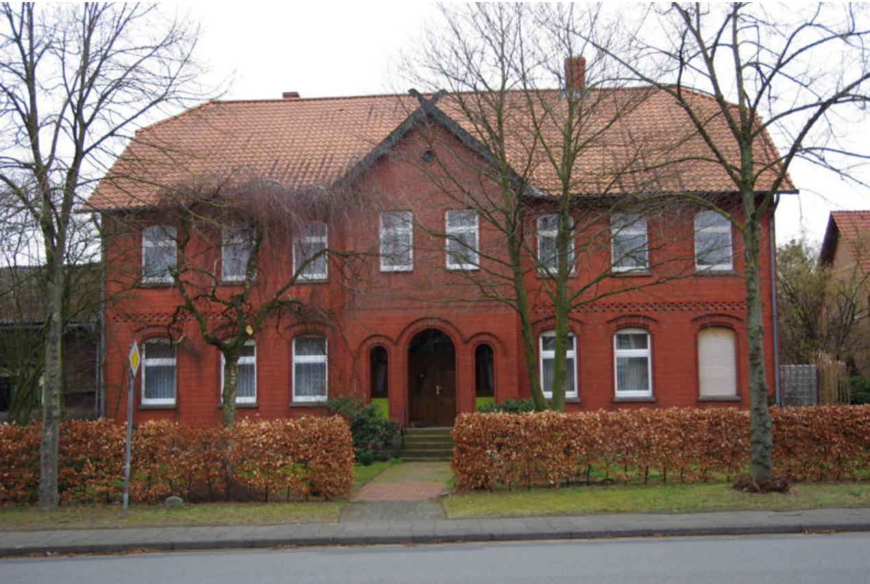
Die Erhaltung der das Ortsbild prägenden Altgebäude bildet nach wie vor ein Kernanliegen der Dorfentwicklung (Tülau)
