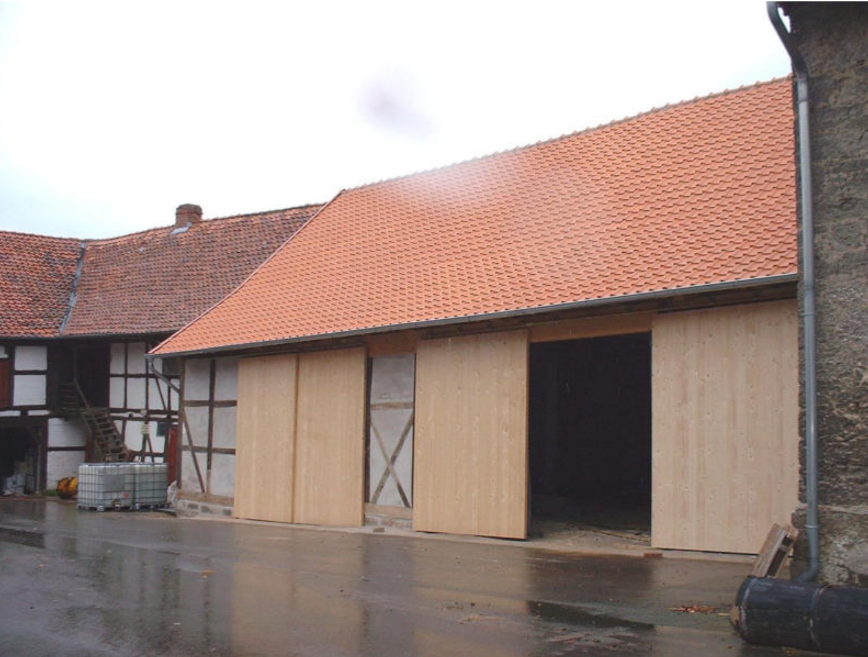
... Anpassung mit vergrößerten Toren, Stützenentfernung und Bodenbefestigung
