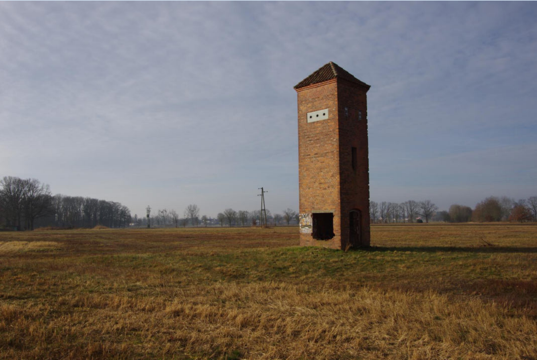
Croya – ehemaliger Trafoturm
